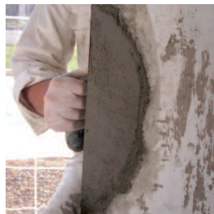
Réparation d'angles et arêtes – seulement une des nombreuses possibilités d'utilisation du mortier de réparation universel PCI Nanocret R2.
